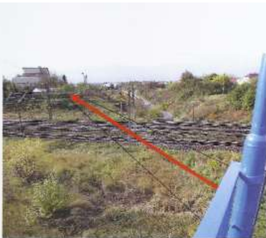
Zdj. Nr 5 – widok z istniejącej kładki w kierunku ul. Ułanowskiej (Zagórze).
